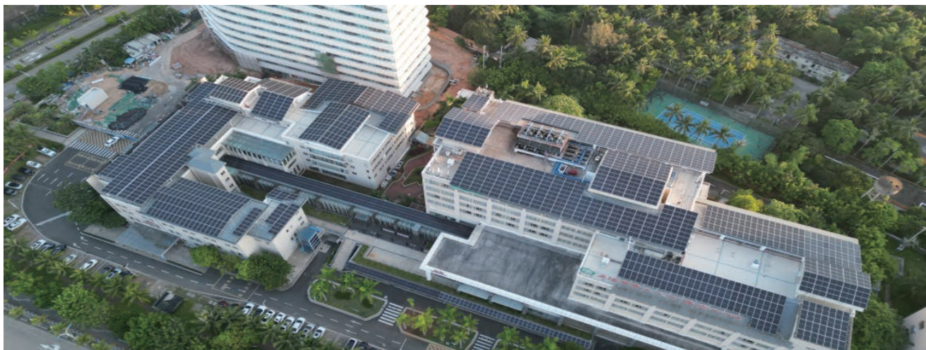
海南屋顶项目 安装时间： 2023
