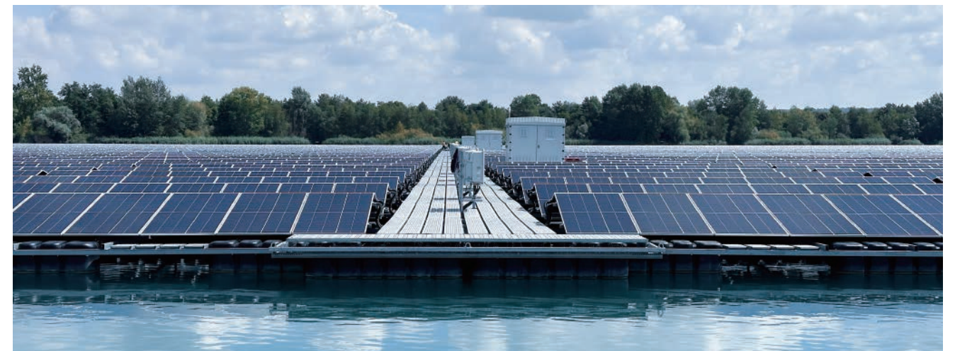
德国漂浮电站项目 安装时间： 2024
