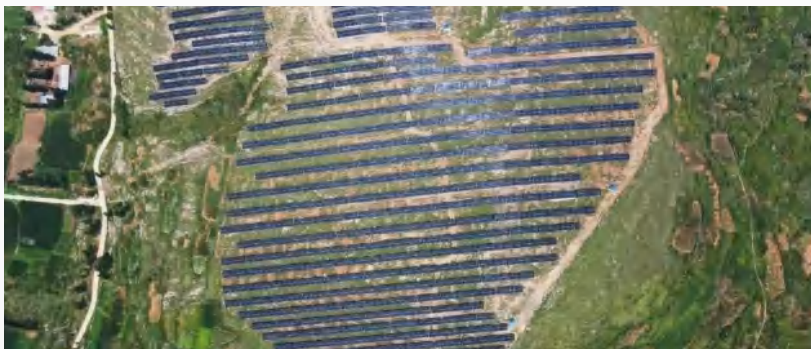
山东泰安角峪镇7.767MWp电站项目鸟瞰图
